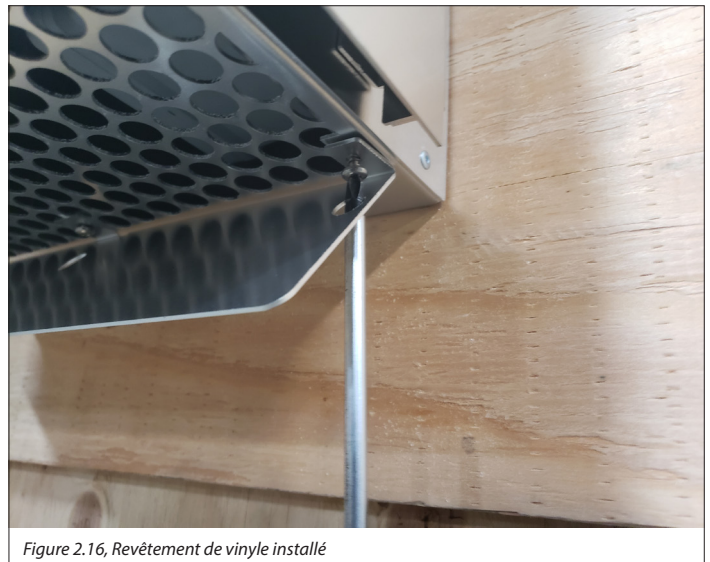
Figure 2.16, Revêtement de vinyle installé
