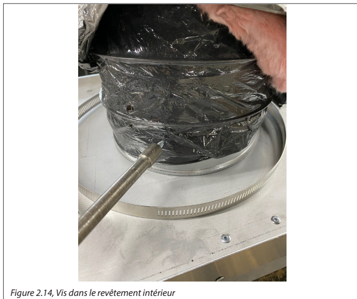
Figure 2.14, Vis dans le revêtement intérieur
