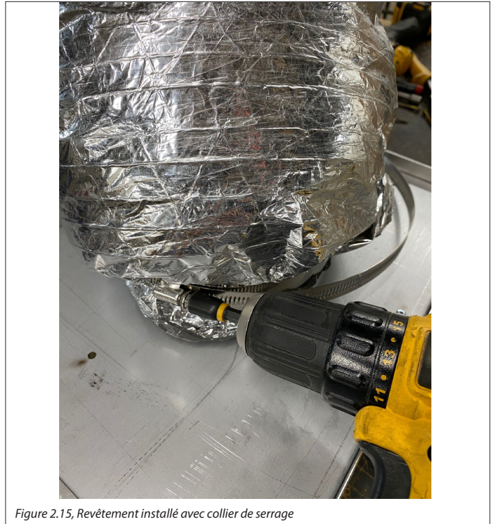
Figure 2.15, Revêtement installé avec collier de serrage
