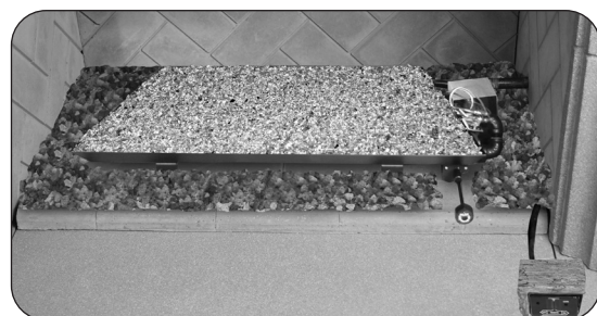
Fig. 17-4 Place vermiculite
