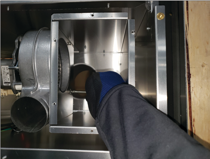
Figure 5.6, Retrait des (3) vis de fixation du ventilateur
