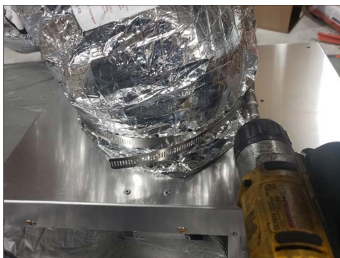
Figure 2.17, Revêtement installé avec collier de serrage
