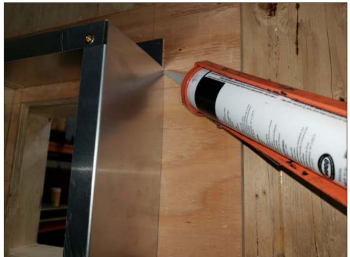
Figure 2.10, Appliquez le scellant silicone tout autour (en périphérie)
