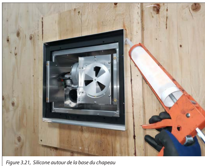
Figure 3.21, Silicone autour de la base du chapeau
