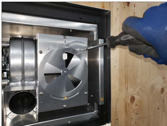
Figure 5.2, Vis de l'évacuateur
