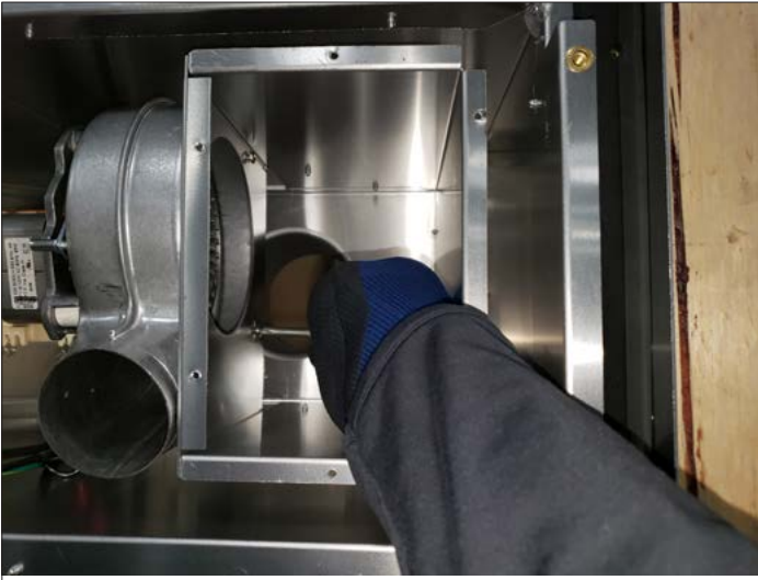
Figure 5.6, Retrait des (3) vis de fixation du ventilateur
