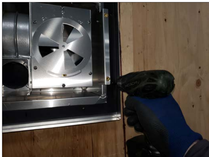
Figure 3.20, Le chapeau est fixé dans le mur
