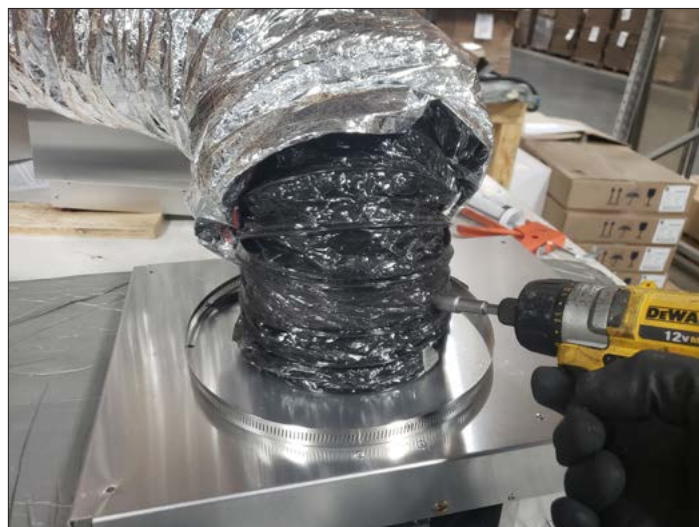
Figure 2.16, Vis dans le revêtement intérieur
