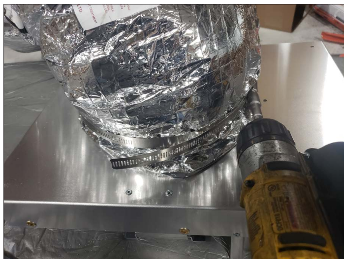
Figure 2.17, Revêtement installé avec collier de serrage
