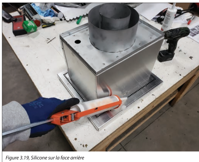
Figure 3.18, Calfeutrage au silicone résistant aux intempéries
