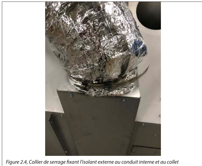
Figure 2.4, Collier de serrage fixant l'isolant externe au conduit interne et au collet
